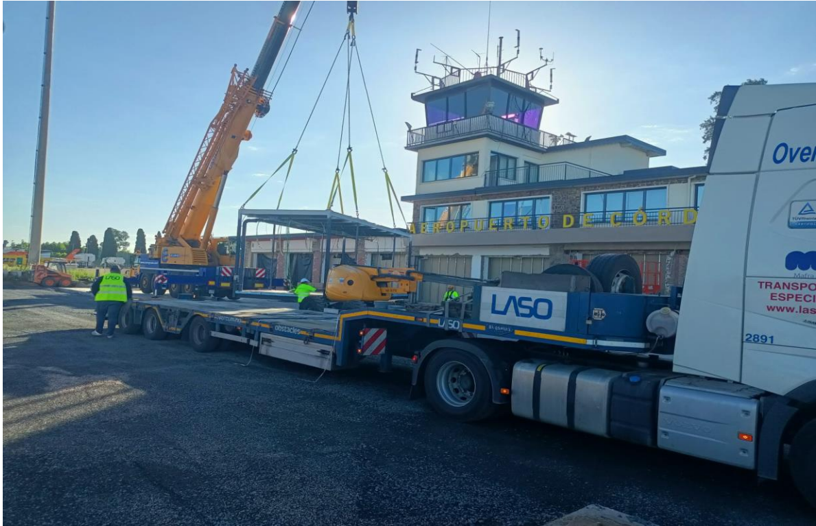
Imagen de los camiones con los módulos en el aeropuerto.
